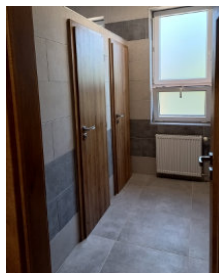
Toalety po rekonštrukcii
