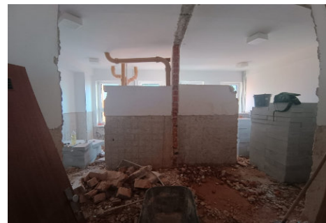
Priebeh rekonštrukcie toaliet
