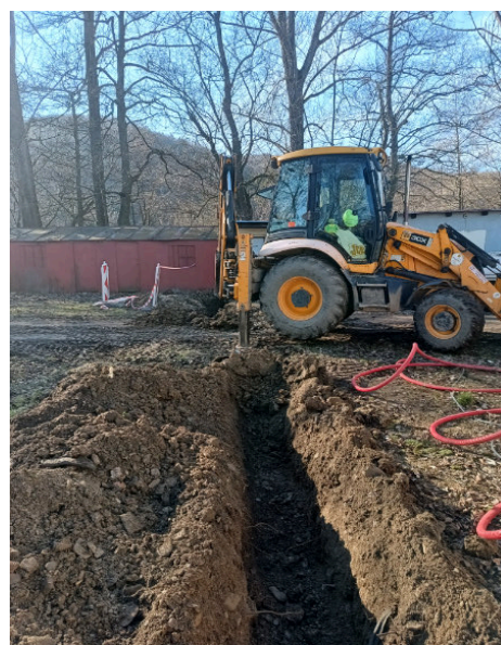
Zemné a výkopové práce. Marián Janiga
